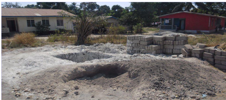
Hier worden toiletten gebouwd.
